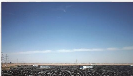
青海格爾木20MW電站
