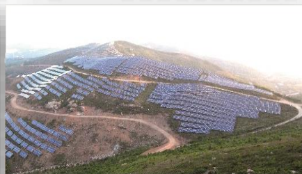
遼寧錦州10MW電站
